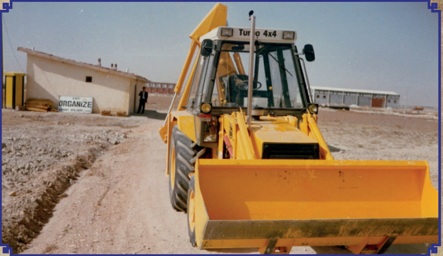
2. OSB'deki alt yapı çalışmalarını kontrol etmek için yapılan şantiye binası ve bölgenin ilk iş makinelerinden bir fotoğraf- 1991
