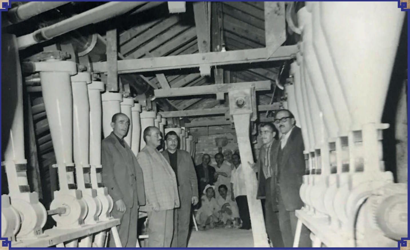
1973 yılında Konya'da un fabrikası montajı yapan ekipten bir fotoğraf.
