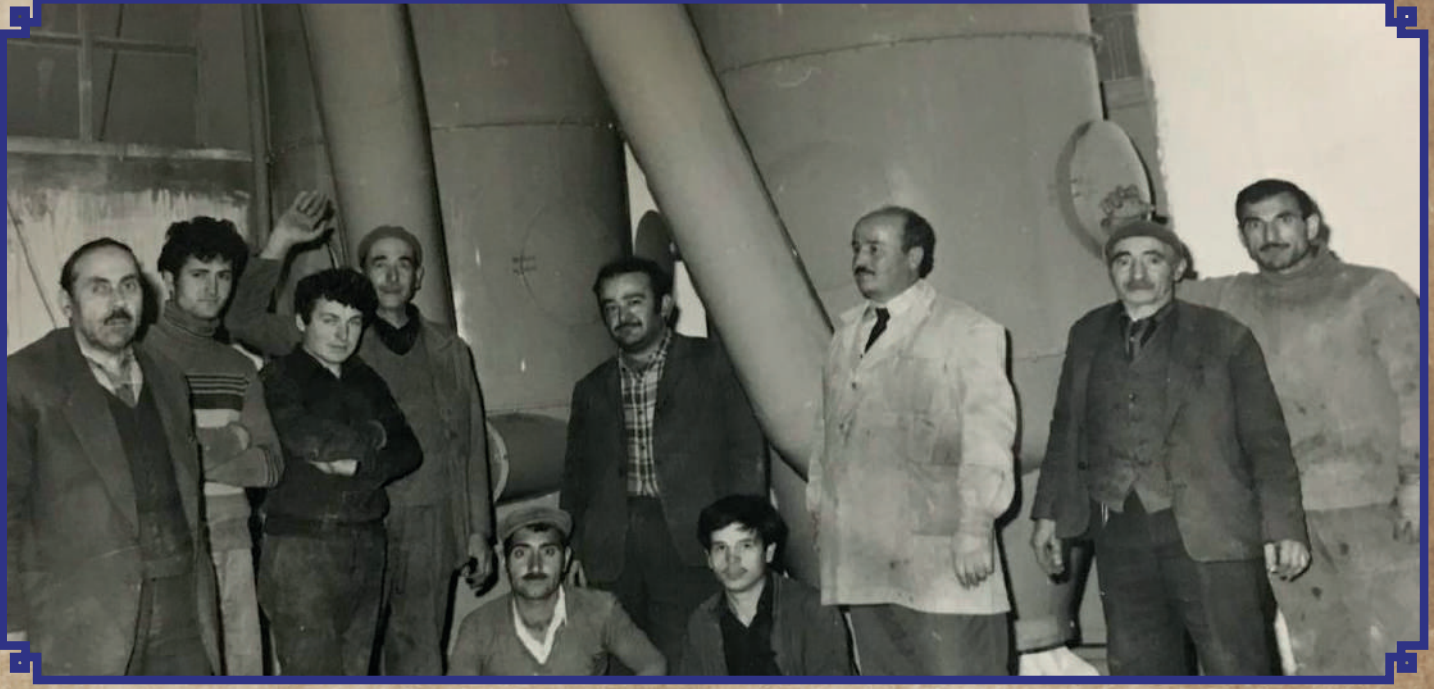
1973 yılında Konya'da un fabrikası montajı yapan ekipten bir fotoğraf.
