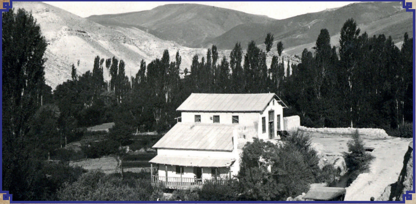
Meram Dere Elektrik Santrali -1950'li yıllar
