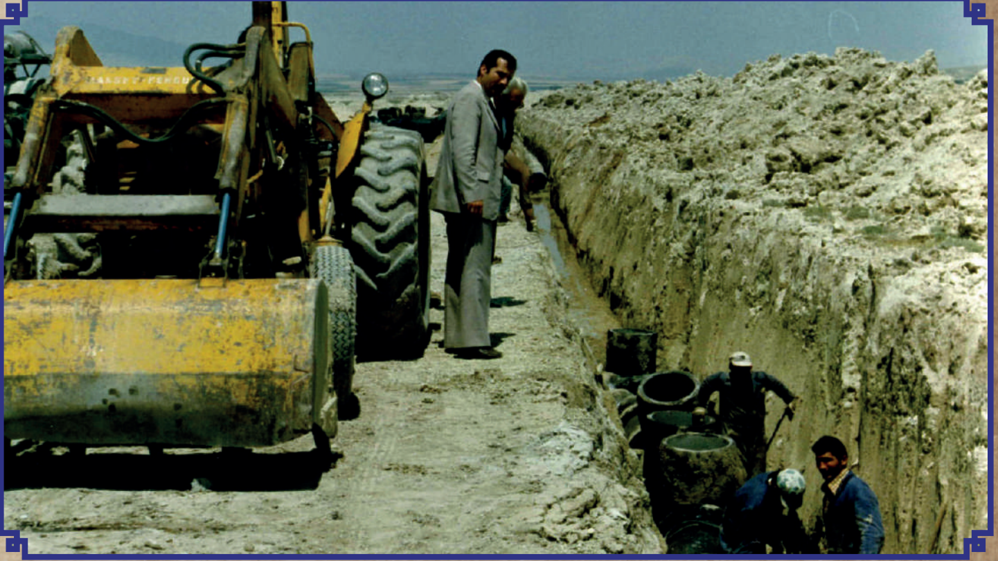
2. Organize Sanayi Bölgesi'ndeki ilk alt yapı çalışmaları. Kanalizasyon ve yağmur suyu alt yapı çalışmalarından bir fotoğraf- 1985
